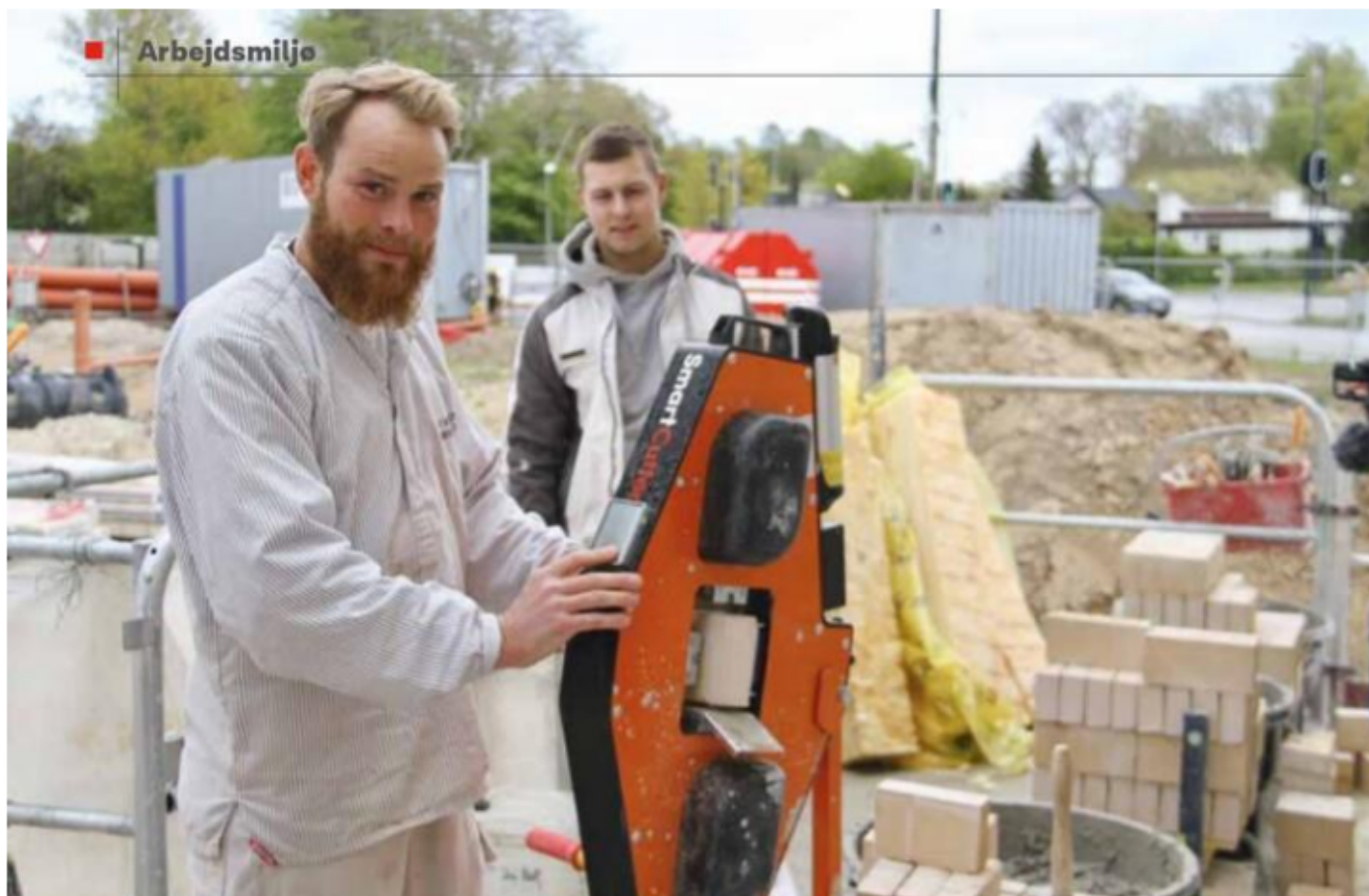
Til de store mængder sten, murere hver dag klipper, skal udstyret bare være i orden. Med el-stenklipperen kan "den gule" (manuelle) godt blive smidt til skrot, mener Tobias Zander Haug. Bag ham murerlærling Rasmus Holst.
